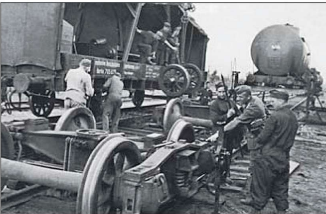
Слева: Участок Польско-Советской границы между станцией Тересполь и Брест после нападения немцев на СССР. На этом участке находился пункт смены вагонных тележек с «европейской» колеи на «русскую». Для ускорения процесса перевода своего подвижного состава на наши рельсы немцы использовали еще и передвижные мастерские. На снимке запечатлен момент смены вагонных тележек в «полевых» условиях. Справа: Немецкий товарный паровоз серии 57 идет по «перешитой» ветке в Инкермане, Крым. На переднем плане можно угадать горы пустых бутылок из-под крымского шампанского, производимого Инкерманским заводом шампанских вин. Лето 1943 год.
