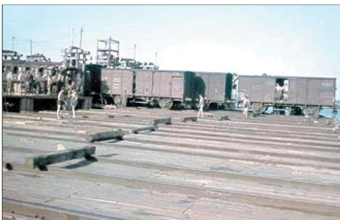
Слева: Импровизированная переправа железнодорожных вагонов DRG на левый берег Днепра в районе Херсона. Снимок сделан в июле 1943 года. При отступлении Красной Армии почти все мосты через Днепр были взорваны, поэтому немецким железнодорожникам при помощи инженерно-саперных подразделений Вермахта приходилось придумывать самые разнообразные способы переправы эшелонов через водные препятствия. Справа: Депо Знаменка. Снимок сделан весной 1943 года. Знаменка для DRG была ключевым узловым пунктом на Южном направлении. По фотографии видно, насколько был разнообразным локомотивный парк DRG, работающий на восточном фронте. Здесь запечатлены как старые грузовые немецкие паровозы, например, серии 55, 56, 57, 58, 93, так и новый военный локомотив серии 52. Также различим и пассажирский паровоз серии 38. Знаменка была освобождена от оккупации 8 декабря 1943 года.
